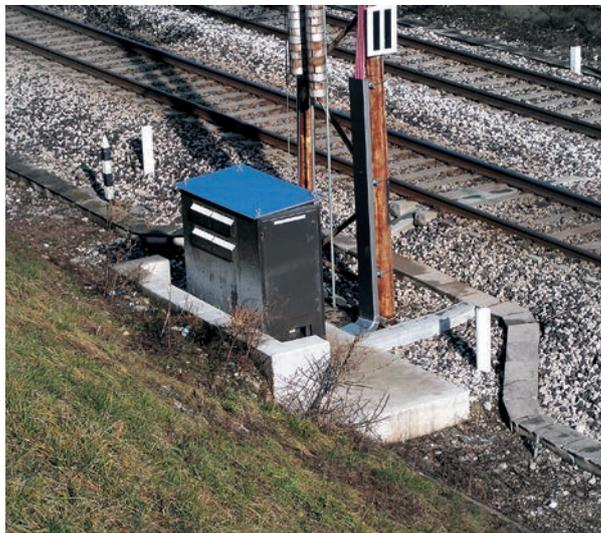
Sezionatore unipolare o bipolare di messa a terra in esecuzione estraibile a bordo quadro per esterno o per installazione in galleria
